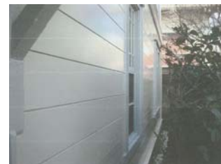
修理後 (板張り部の浮き釘処理 及び塗装工事等)
