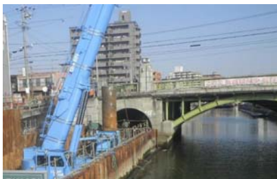
護岸整備状況 (住吉橋下流)
