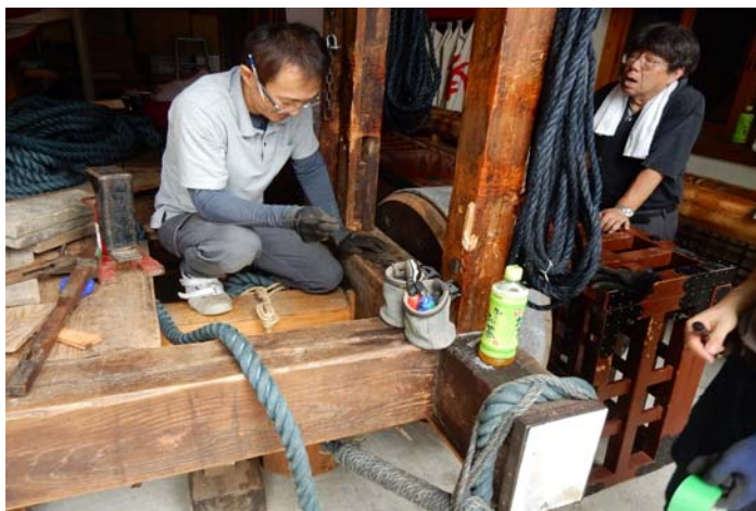
若宮八幡宮福祿寿車修理事業の作業立ち会い
