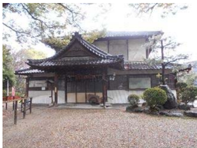
第176号 旧鳴海町役場 (緑区鳴海町)
