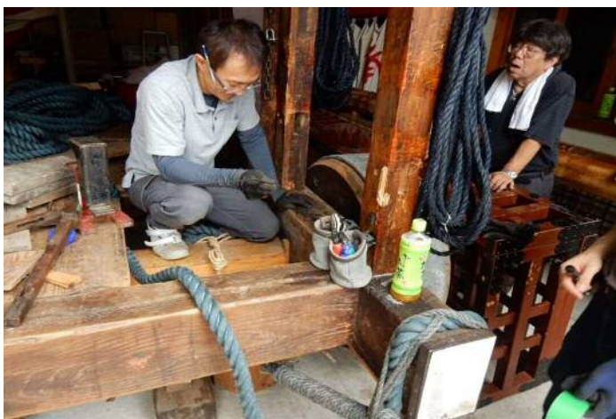
若宮八幡宮福祿寿車大柱修理事業 (修理事業者・保存会・教育委員会で作業方法を確認)
