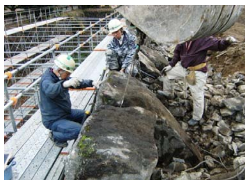
石垣の解体修理
