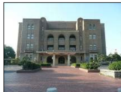
写真 2-124 公会堂 (市都市景観重要建造物)
