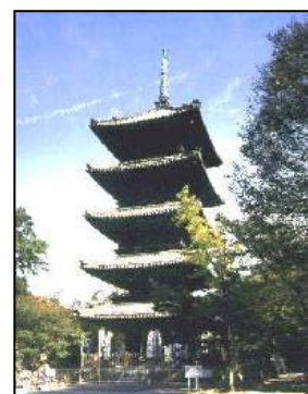
写真 2-98 興正寺五重塔 （重要文化財）
