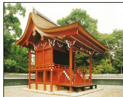
写真 2-91 富部神社本殿 (重要文化財)
