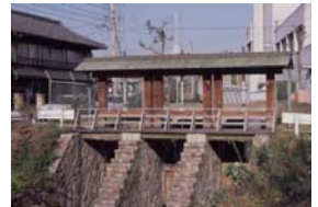
黒川樋門（再建）
