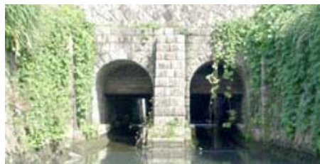
もとより 元杵樋門
