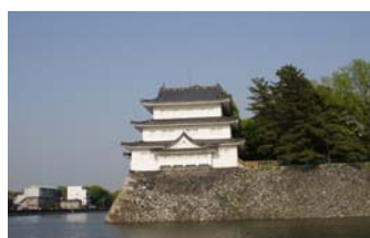
西北隅櫓（重要文化財）
