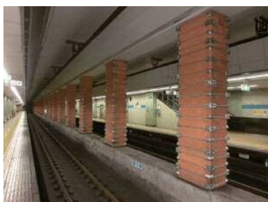
《図 4-2-9 地下構造物の耐震化の例》
