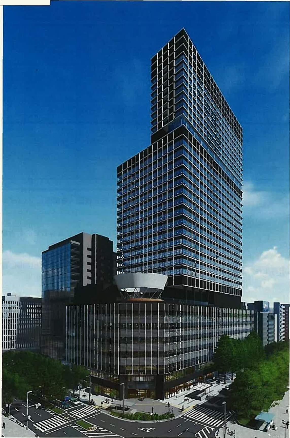
広小路久屋東交差点より南東を望む
