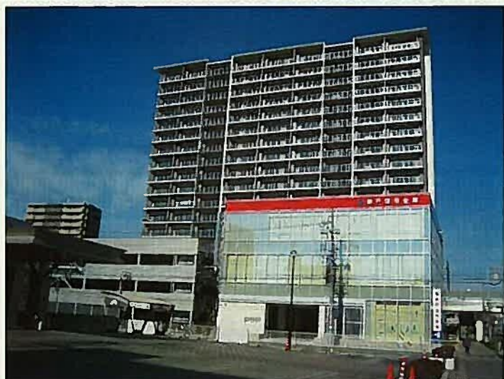
C街区施設建築物
