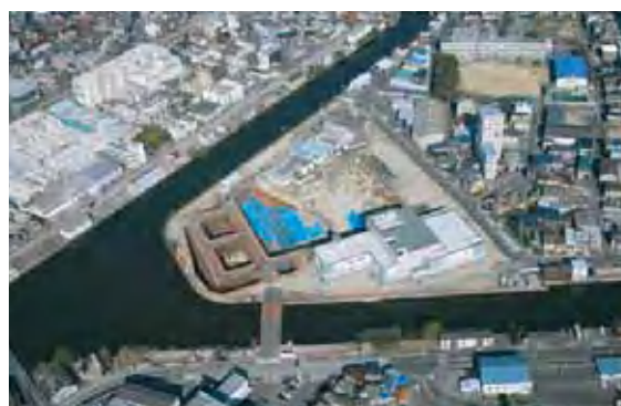
■露橋水処理センター（建設中）
