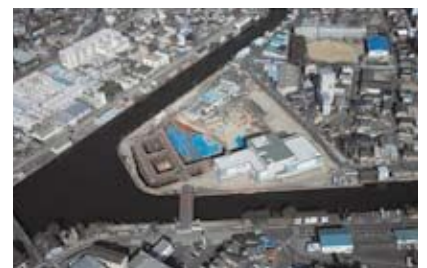
露橋水処理センター（建設中）
