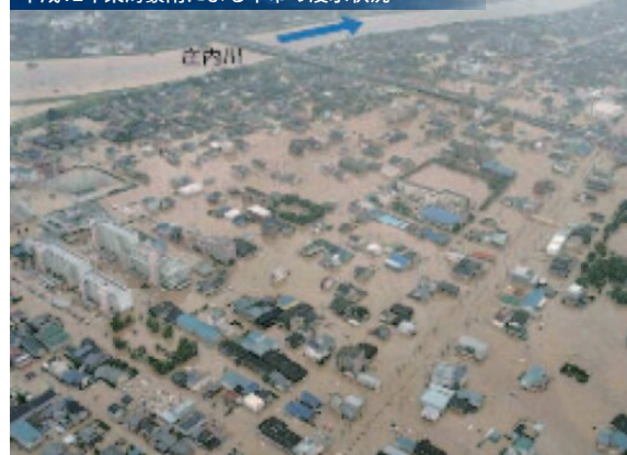
平成12年東海豪雨による本市の浸水状況
