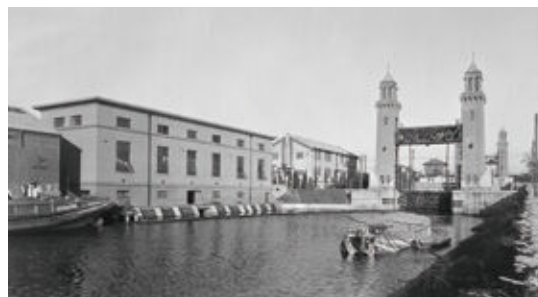
松重ポンプ所(左の建物)と松重閘門
