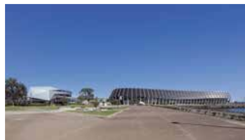
名古屋市国際展示場 第1展示館 及び コンベンションセンター
