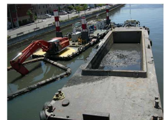
治水整備に合わせたヘドロの除去
