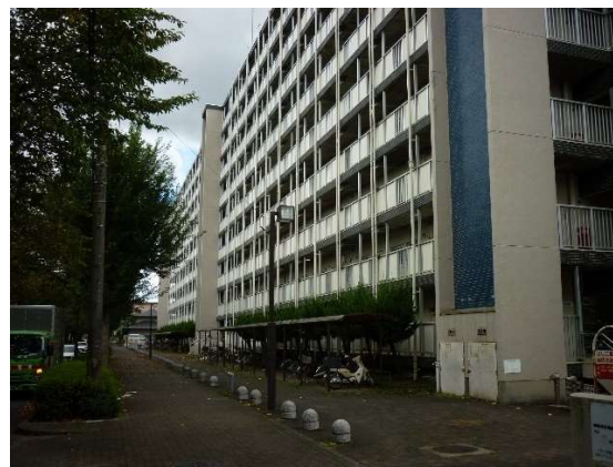
北西方より調査対象地
