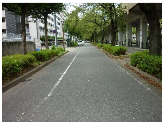
東方より北側道路
