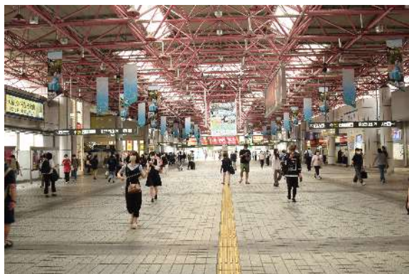
連絡通路(床、壁面、天井トラス)
