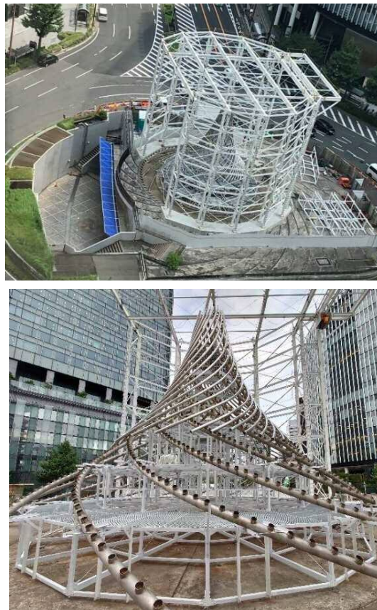
（化粧パイプ撤去中）
