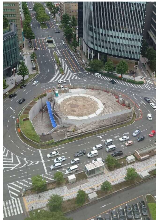
（上部撤去完了）
