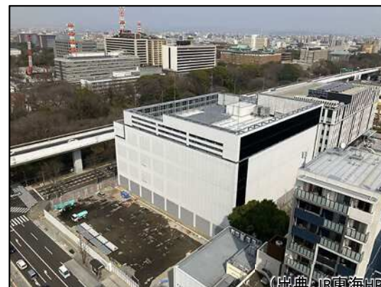
地上躯体工事完了(令和5年3月)
