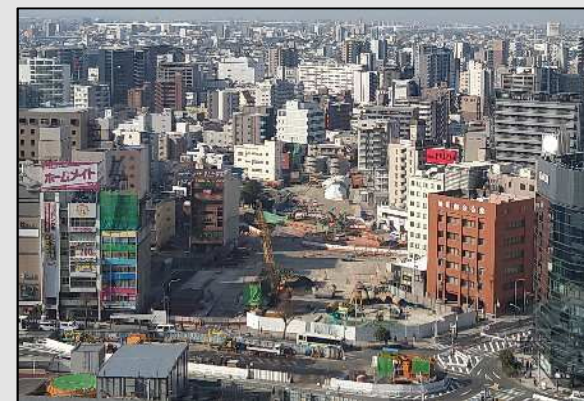
2 名古屋駅西側の状況(令和6年2月)
