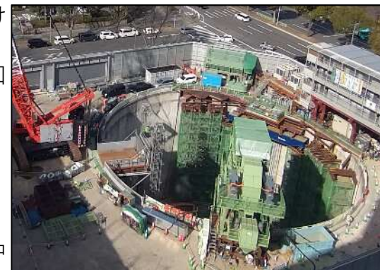
シールド掘進準備工事(令和6年2月)
