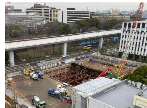
地下躯体構築工(令和3年3月)
