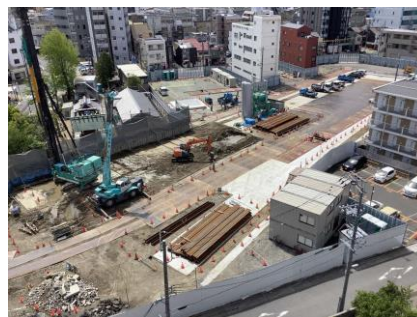
【西工区】準備工 (地中連続壁) (令和3年4月)
