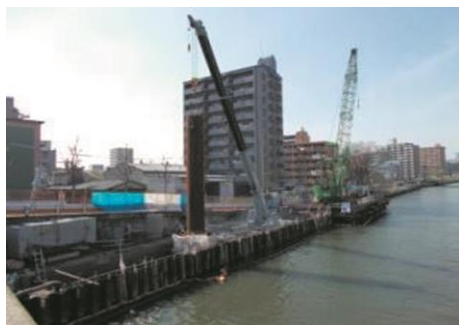
堀川の護岸改修
