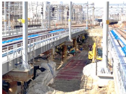
【中央東工区】準備工 (盛土撤去) (令和3年3月)
