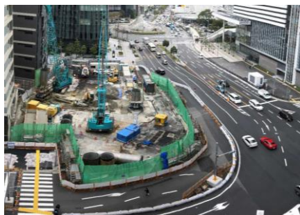
【東山線工区】準備工 (立坑・地中連続壁) (令和3年3月)
