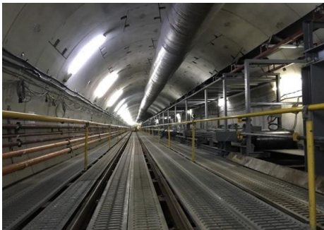
名古屋中央雨水調整池（工事中）
