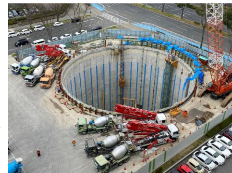
非常口躯体構築工(令和3年3月)
