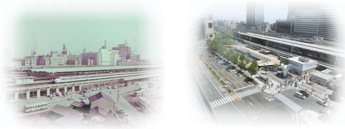
東海道新幹線開業時の名古屋駅西側（左）と現在の名古屋駅西側駅前広場（右）
