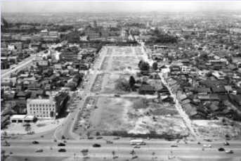
戦災復興事業による 久屋大通の整地工事が始まる
