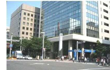
【参考写真】広小路通 名古屋広小路ビル (屋上緑化)
