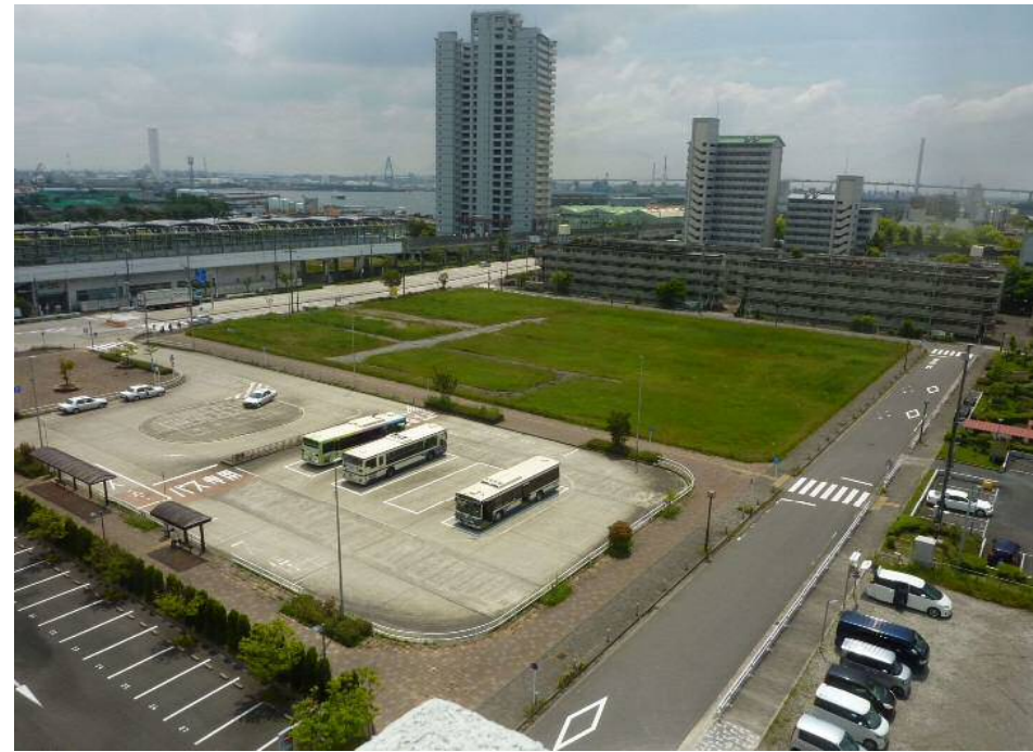
北西側から見た対象敷地及び④敷地
