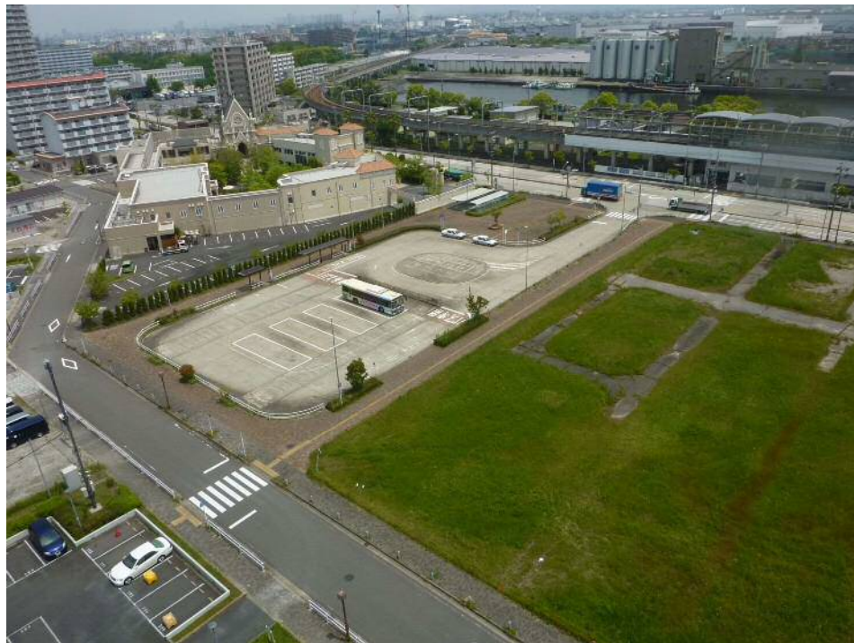
南西側から見た対象敷地及び③④敷地
