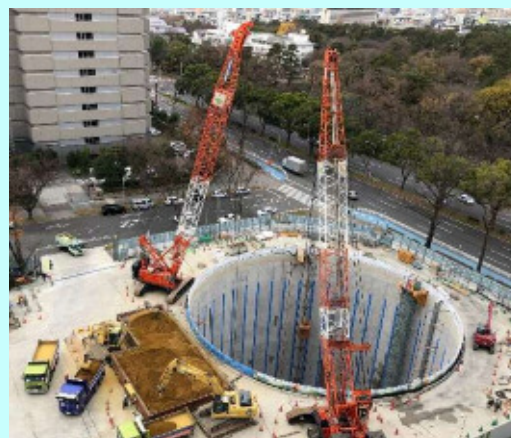
立坑掘削工(平成30年12月)
