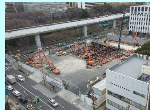
掘削工（令和2年2月）
