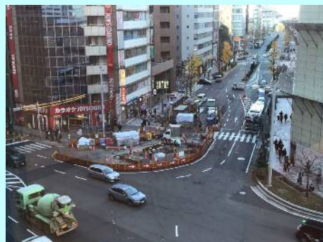
【駅東側】準備工事（支障物件移転） （令和元年12月）
