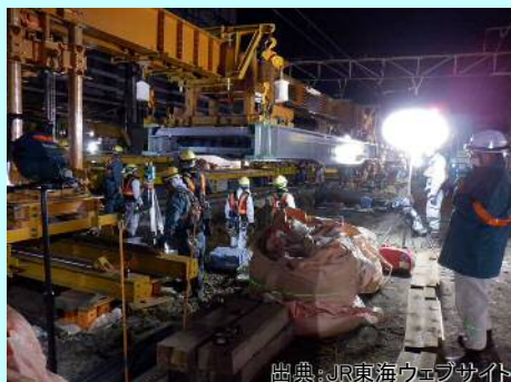
【在来線部】工事桁架設工 （令和元年12月）
