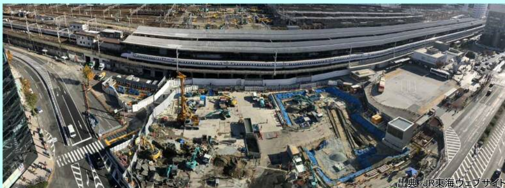
【新幹線部】準備工事（支障物件移転）（令和元年12月）
