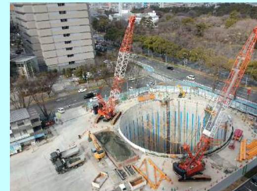
非常口掘削工（令和2年2月）
