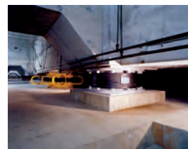
耐震性能の強化の例（免震装置）
