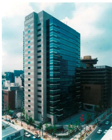
写真 2-16-2 総合設計制度活用事例 中区役所朝日生命共同ビル (平成3年竣工時写真)
