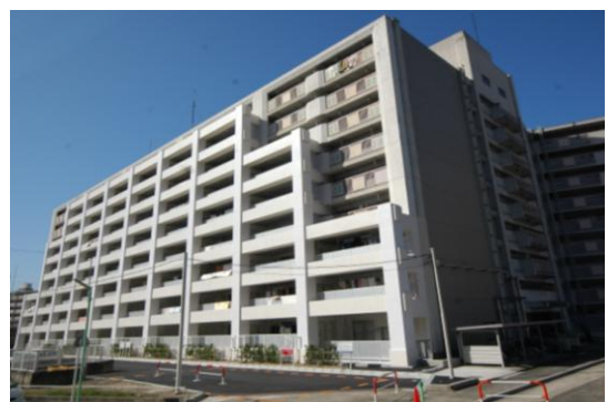
写真2-13-2 市営住宅の耐震改修(アウトフレーム工法)
