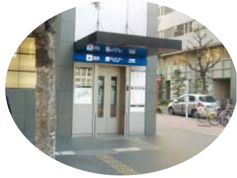
交通施設のバリアフリー化 (地下鉄伏見駅)
