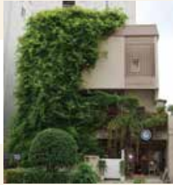
BLUE BLUE NAGOYAの 建物の緑化 中区栄三丁目
