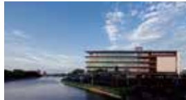
愛知時計電機株式会社 新事務棟 熱田区千年一丁目
