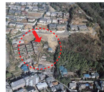
滑動崩落に伴う被害
