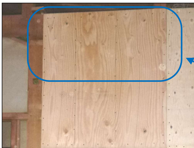
No. 8 壁① 1階 X7-Y10~11 構造用合板上部
