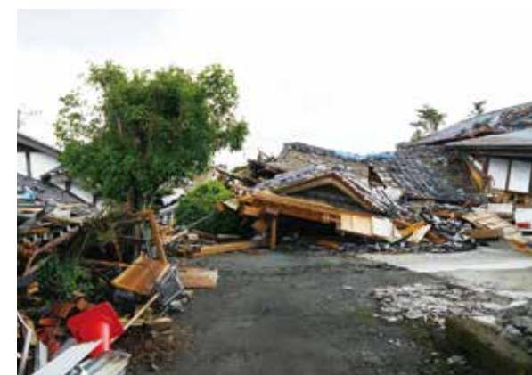
倒壊した木造住宅
