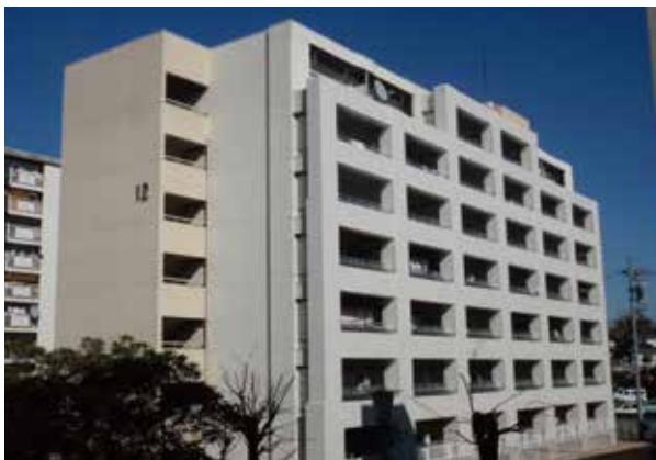
市営桶狭間荘（耐震改修工事完了）
