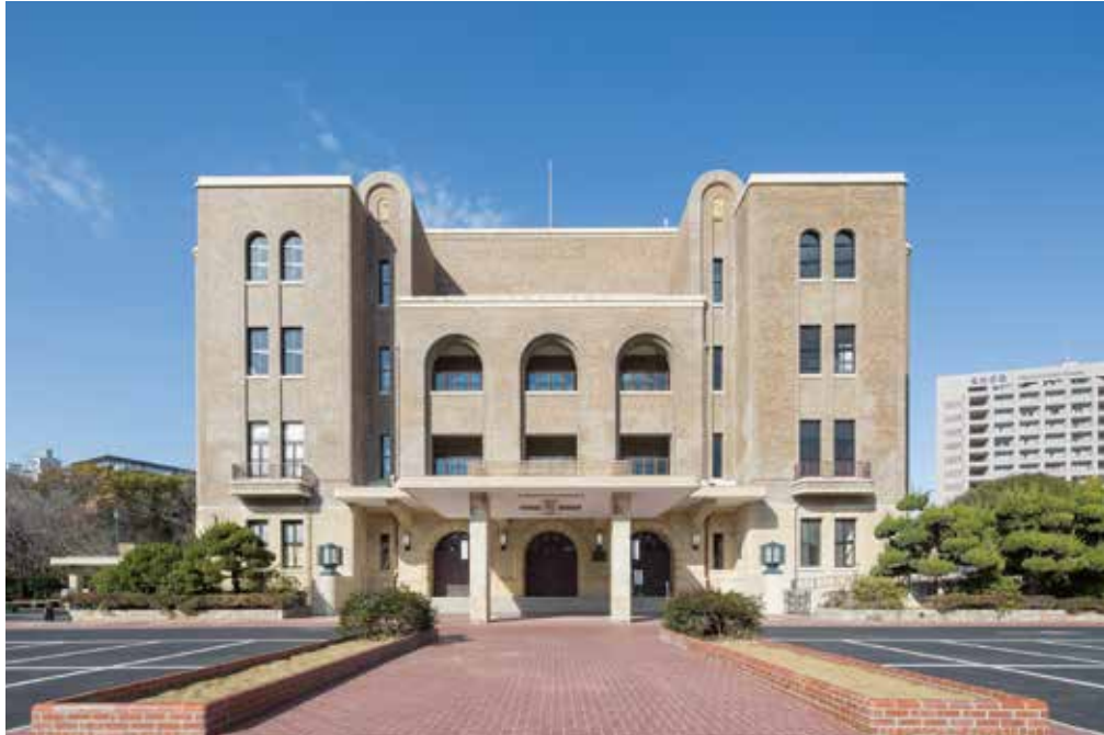
名古屋市公会堂（要緊急安全確認大規模建築物／耐震改修工事完了）
