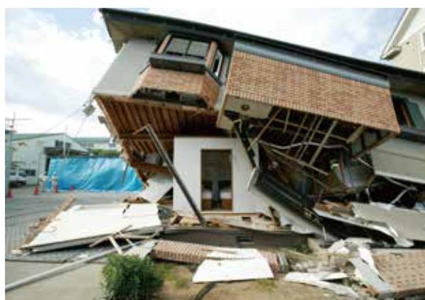
耐震シェルター
