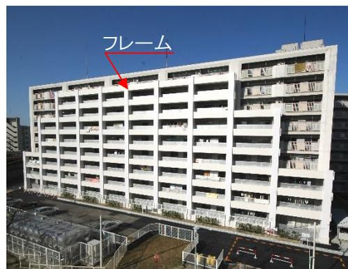
既存建物の外側に新たに柱・はりによるフレームを新設し、建物の耐震性能を向上させる耐震改修工法。住みながら施工できることが特徴。
