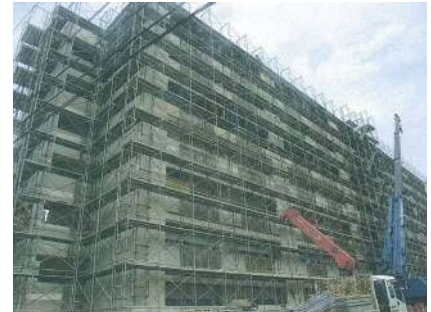
外壁改修中の市営住宅
