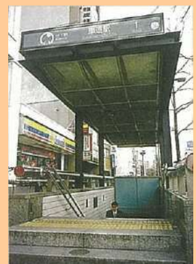
地下鉄車道駅
