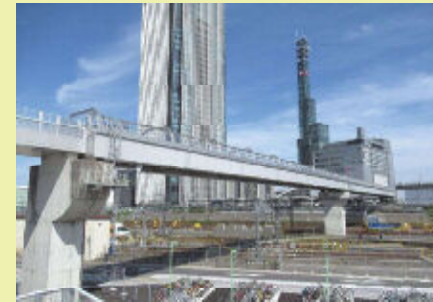
オーバーパスの外観
