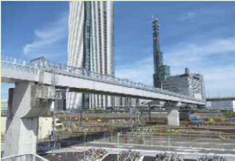
オーバーパスの外観
