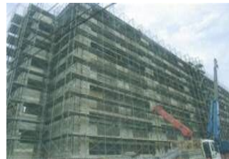
市営住宅の外壁改装
