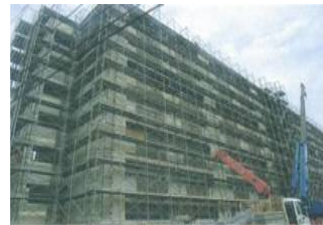
市営住宅の外壁改装
