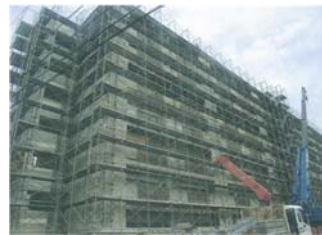
市営住宅の外壁改装
