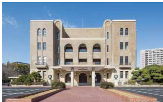
要緊急安全確認大規模建築物の例 名古屋市公会堂(耐震改修済)
