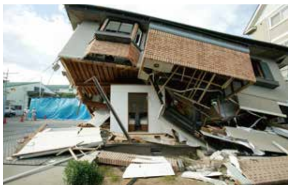
耐震シェルター
