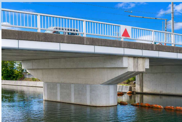
橋りょうの耐震補強
