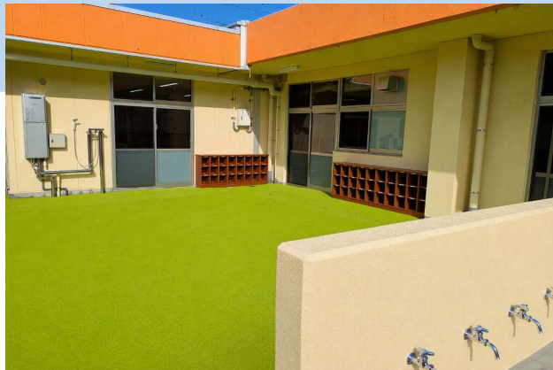
保育所の改修
