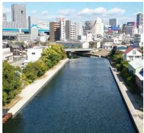
護岸整備状況
