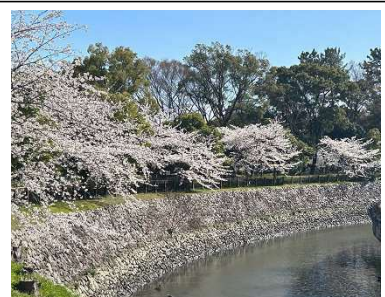
河川改修 (景観に配慮した護岸整備)
