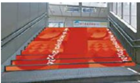
刈谷駅階段(北・南口)
