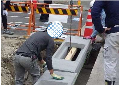
玉掛け作業の状況
