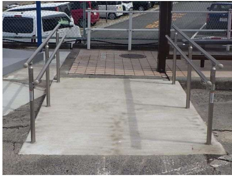
スロープの設置状況
