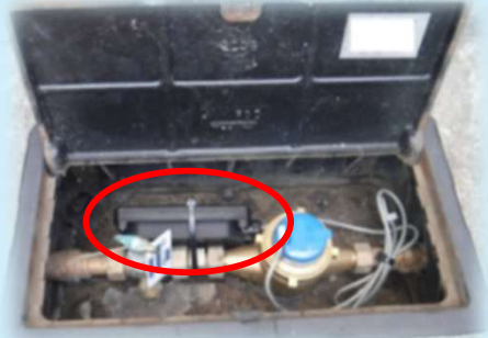
水道スマートメータの設置例 ※赤枠で囲った部分が通信機能をもった端末です。
