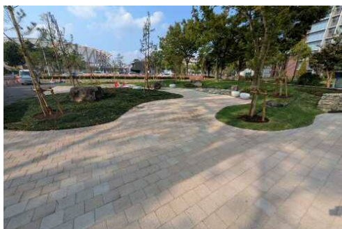
啓発スポットの保水性舗装
